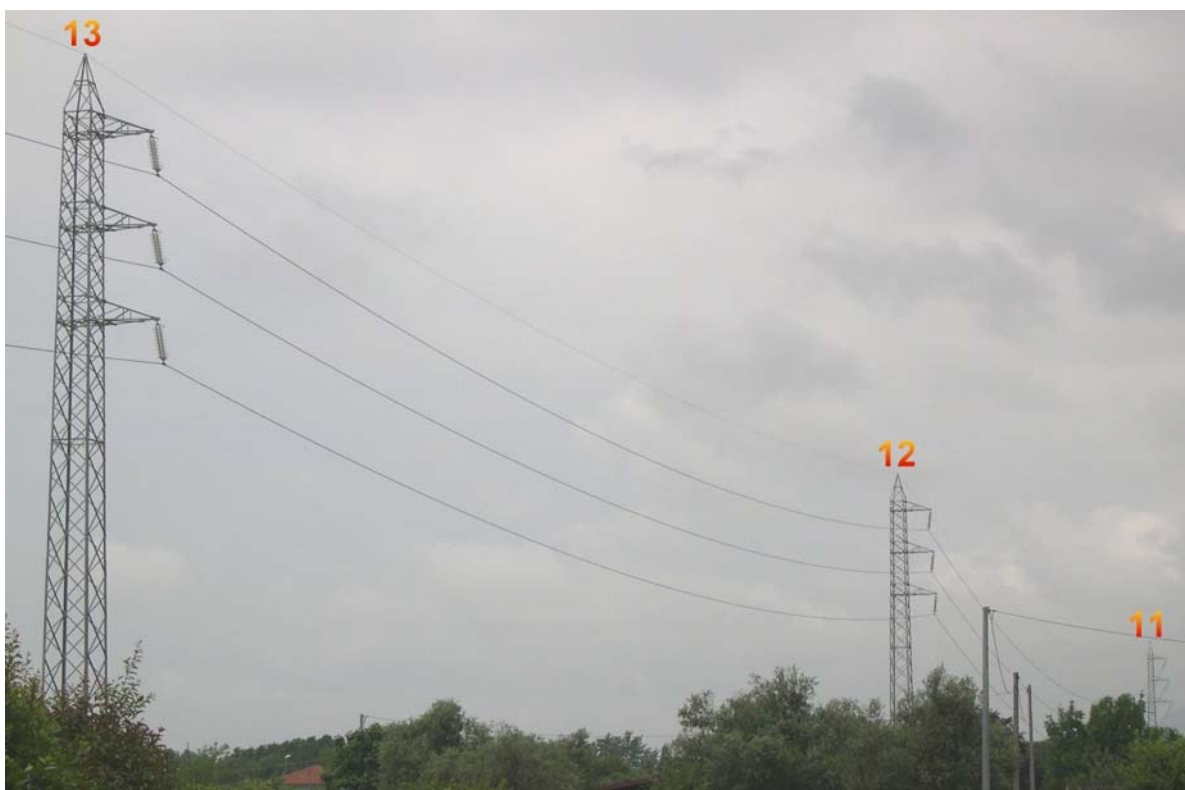
Linea n. 078, sostegni n. 13, 12 e 11 (sostegni a bandiera in sospensione con conduttore in all.-acc. da 31.5 mm di diametro; 3 mensole sul lato nord)
