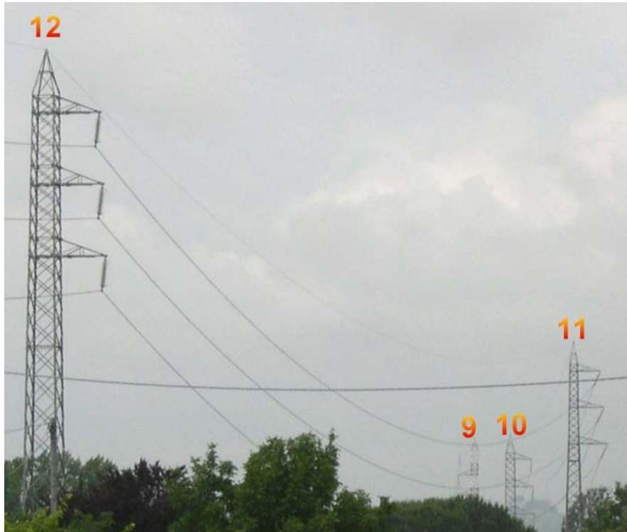
Linea n. 078, sostegni n. 12, 11, 10 e 9 (sostegni a bandiera in sospensione con conduttore in all.-acc. da 31.5 mm di diametro; 3 mensole sul lato nord, tranne il n. 9 con 3 mensole sul lato sud [riconoscibile dal colore rosso e bianco])
