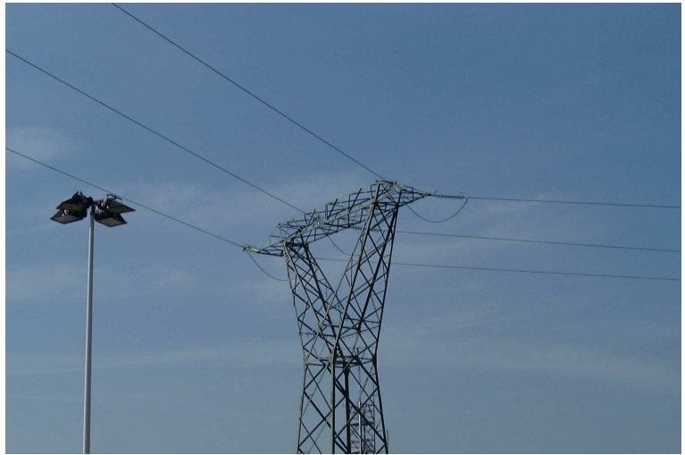
Fig. 3: foto del sostegno considerato nelle figure 1 e 2.
